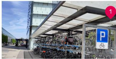
M2: Genügend Veloabstellplätze und ergänzende Veloinfrastruktur bereitstellen
