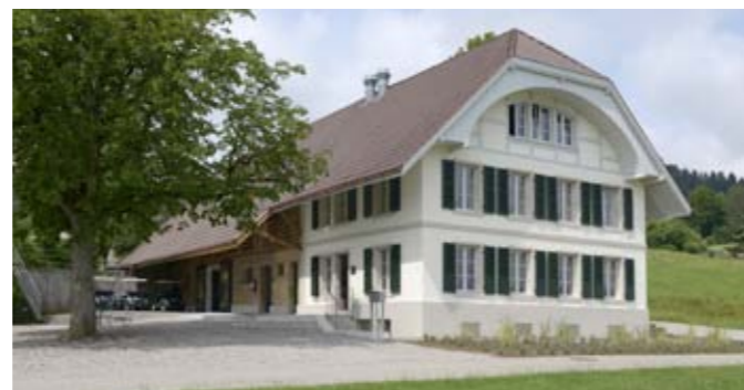
Das ehemalige Bauernhaus «Mürgge» wurde sanft zum Clubhaus umgebaut.
