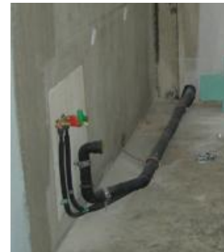
Neue Installation Küche
