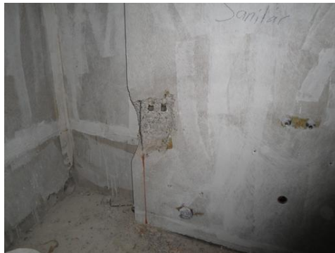
Best. Steigzone (Beton) mit einbetonierten Leitungen
