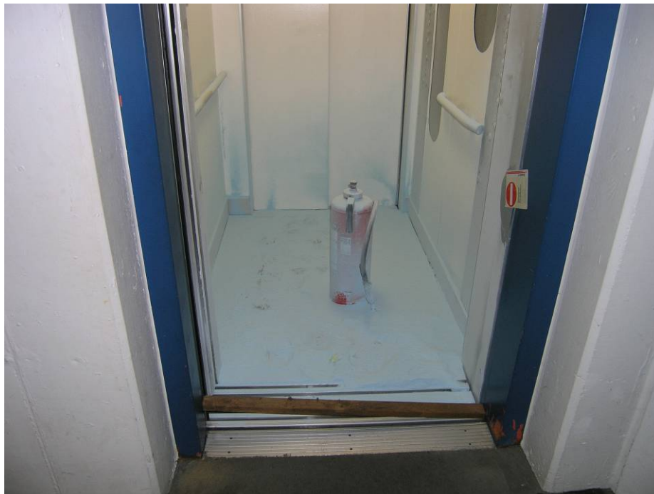
Verwüstung im Parkhaus-Lift durch Vandalen
