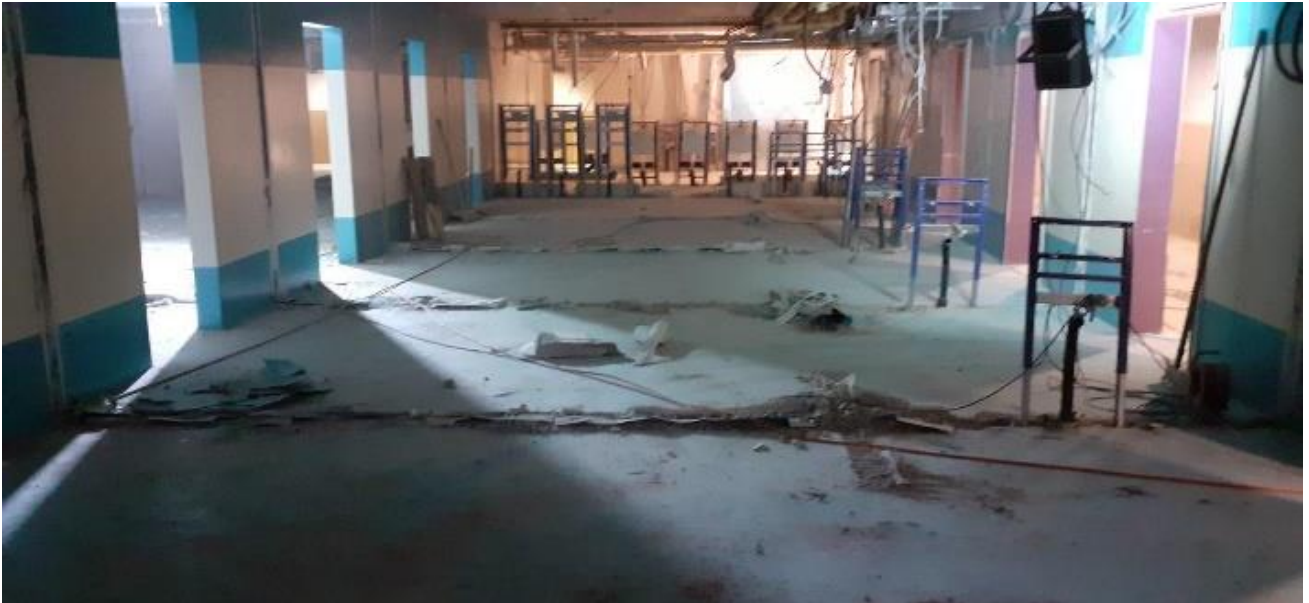
Garderoben Sporthalle Schützenmatt während der Abbrucharbeiten
