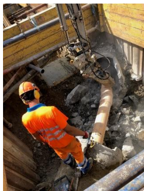
Einbau Rohrleitung Abwasser
