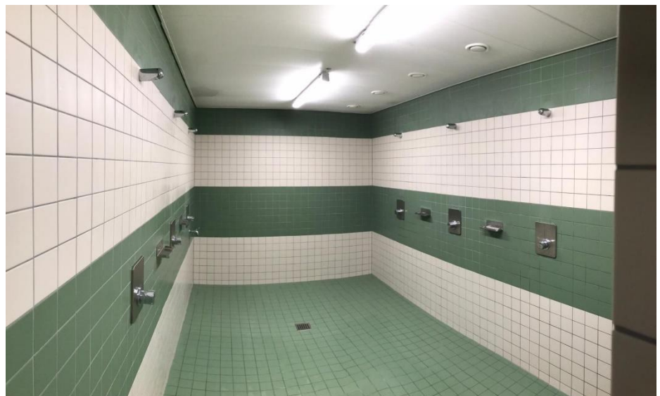
...und Duschen nach der Sanierung
